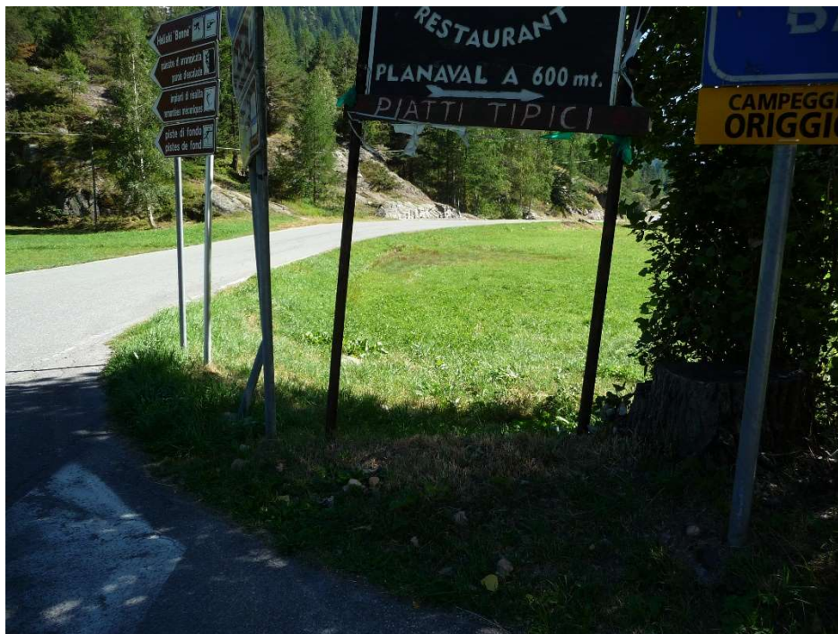
Figura 3 – Particolare di un attraversamento lungo la strada comunale che scende da Planaval verso la strada regionale (sopra); tratto di strada regionale lungo la quale si svilupperà il tracciato della condotta interrata in progetto, immediatamente a monte del punto di confluenza con la Dora di Valgrisenche (sotto).
